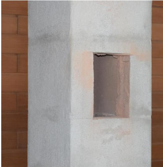
1. Öffnung in Mauerwerk stemmen bzw. Mauerwerk aufbrechen.
