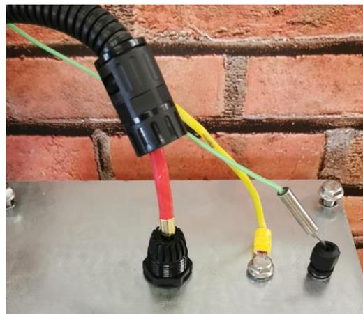
**Beim Verlegen des Hochspannungskabels sollten Radien kleiner 10 cm bzw. das Abknicken des Kabels vermieden werden.**
