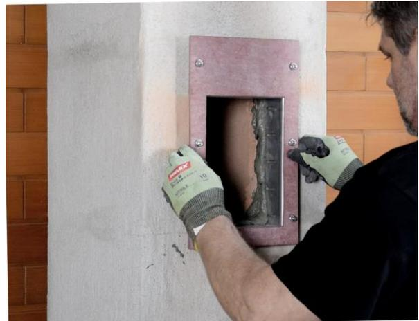
2. Einputzrahmen einfügen. Rahmen mit Mörtel im Mauerwerk einputzen und ausrichten.
