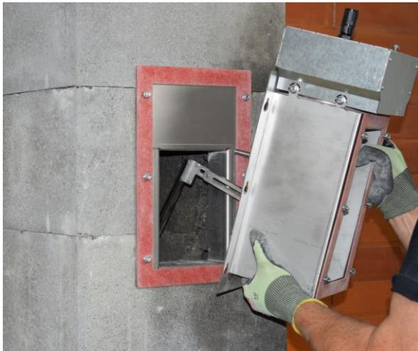
3. Isolator-kammer am Rahmen befestigen. Mittige Ausrichtung der Elektrode prüfen.
